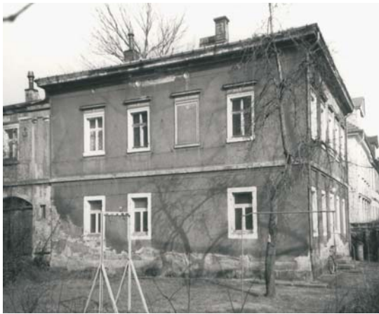
E.-Berger-Straße 3 vor Sanierung
