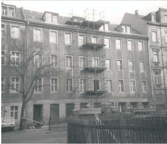
Königstraße 15 vor Sanierung
