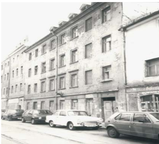
Heinrichstr. 5/5a vor Sanierung
