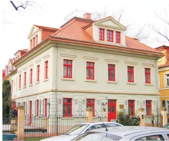
E.-Berger-Str. 3 nach Sanierung
