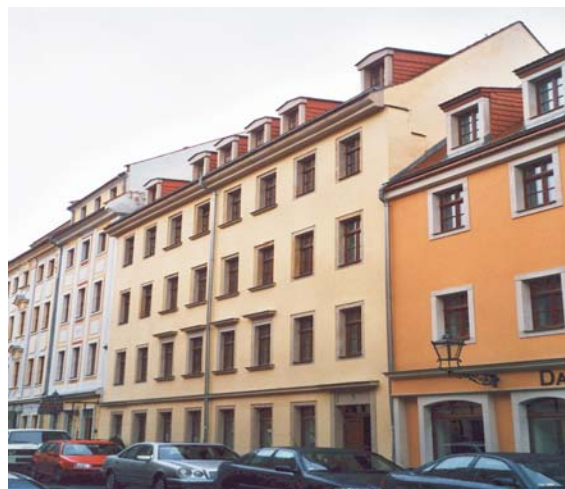
Heinrichstr. 5/5a nach Sanierung
