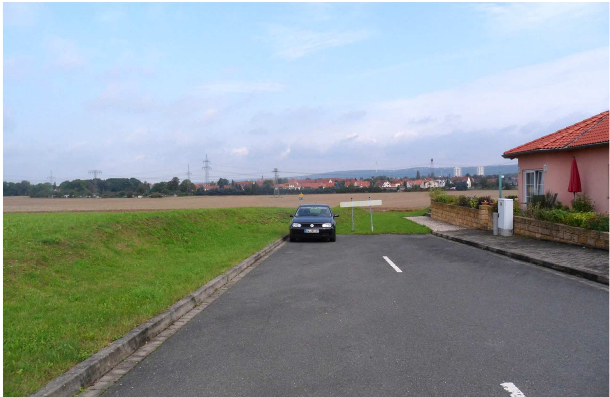
IST-Zustand Ausbauende Straße An der Niederung
