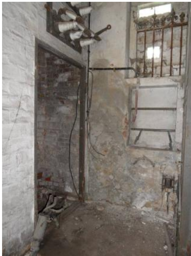
Foto 15: Teil der historischen Fenstervergitterung
