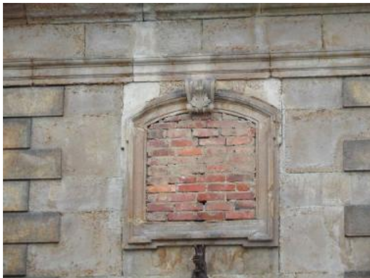
Foto 7: zugemauerte Fensteröffnungen
