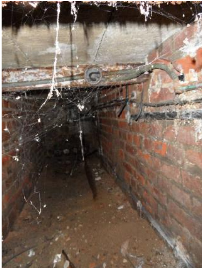
Foto 17: gemauerter Installations- Bodenkanal
