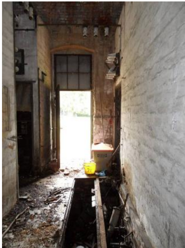
Foto 10: Innenraum mit Blick zur Tür
