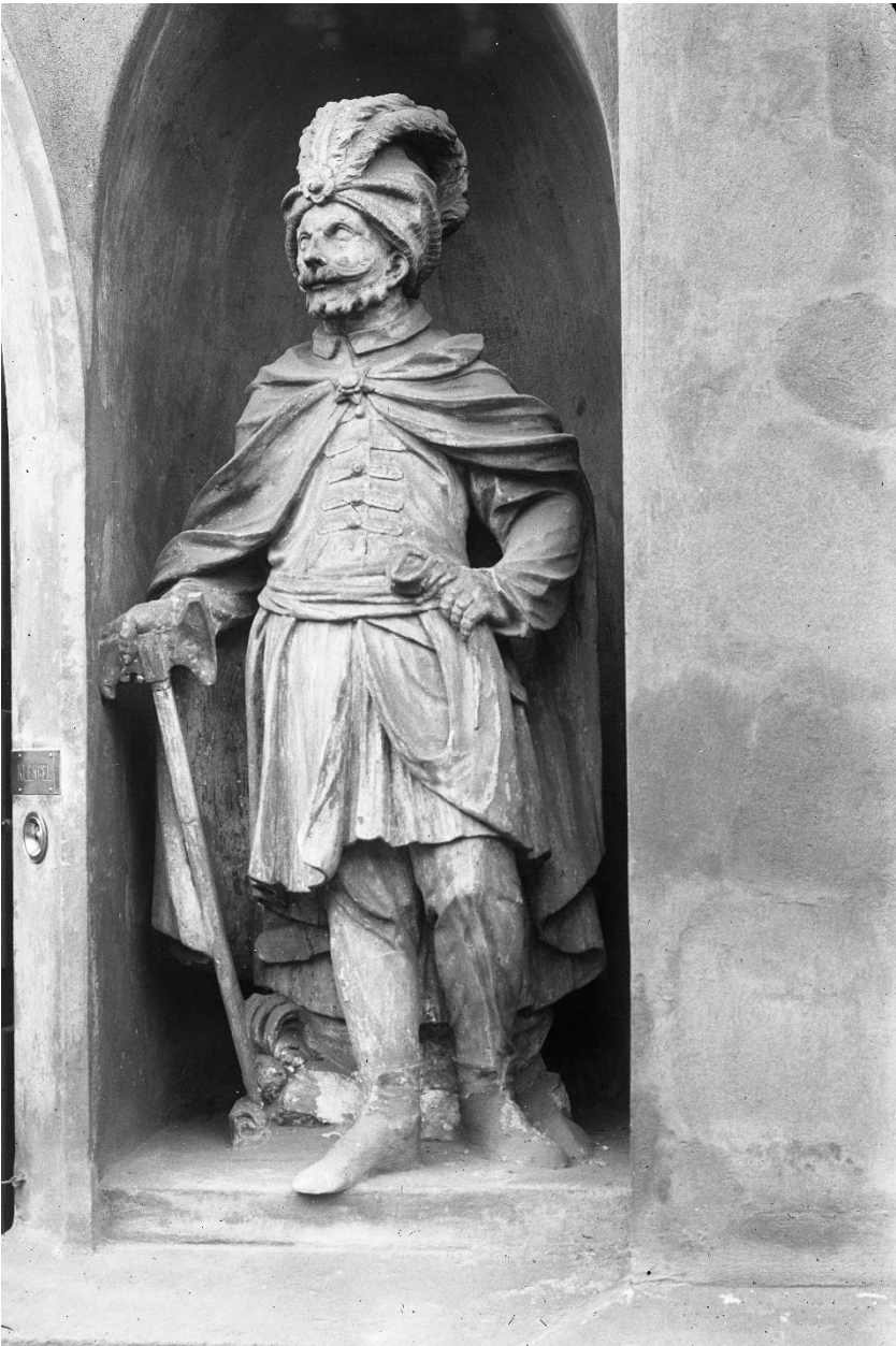
Anlage 1 – Historische Aufnahme „Türke 2“ am Originalstandort
