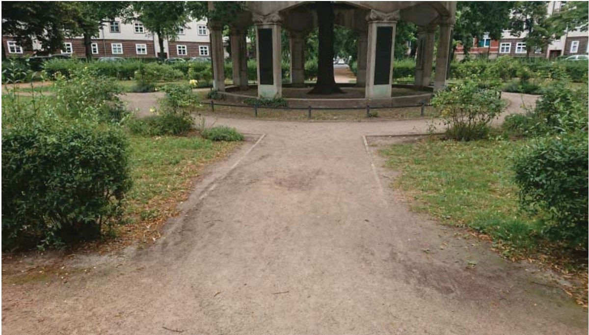
Kirchplatz Laubegast Mai 2020, Zustand der Wege
