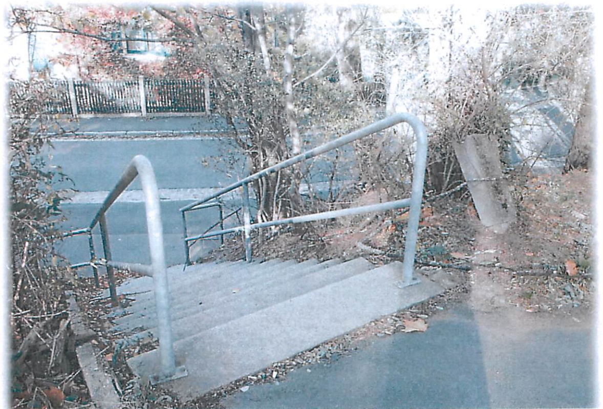
▼ Ansicht der Treppe vom „Klotzcher Weg“ aus
